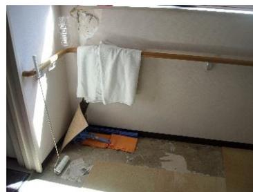
3階南側 壁材欠落
