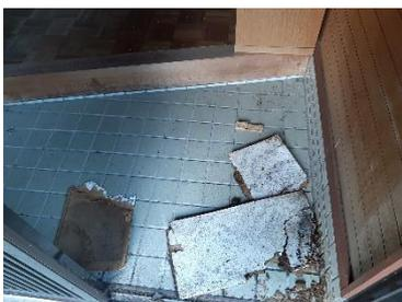
玄関 壁板の欠落
