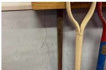
車庫 コンクリート壁の亀裂
