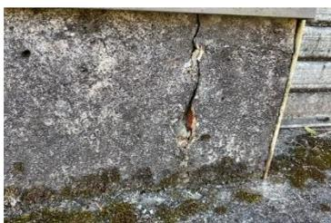
基礎 コンクリートの亀裂
