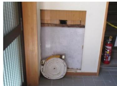
玄関 壁板の欠損
