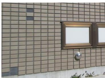
外壁 タイルの欠損
