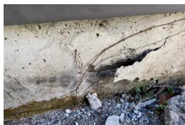
基礎 コンクリートの欠損
